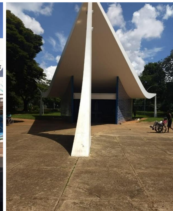
[ Fig. 6 ] Igreja N. Sra. de Fátima, de O. Niemeyer, na Unidade de Vizinhança modelo. Foto das autoras.
